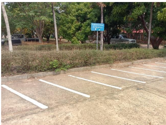
ที่จอดรถสำหรับประชาชนบริเวณด้านหน้า สก.
